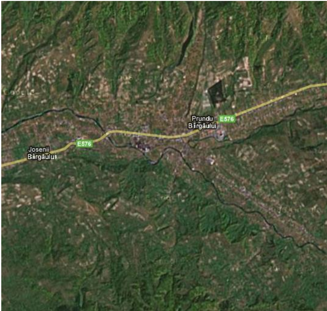
Vedere aeriană asupra satului Prundu Bîrgăului, reședința de comună, Sursa: Google Maps
